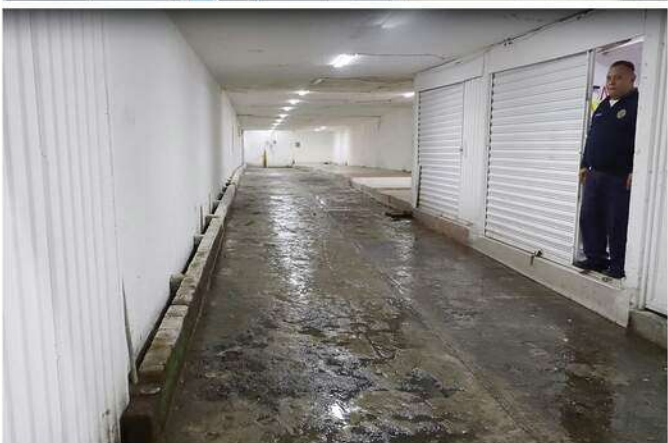
En bajopuentes y estaciones del Metro siguen las obras.
